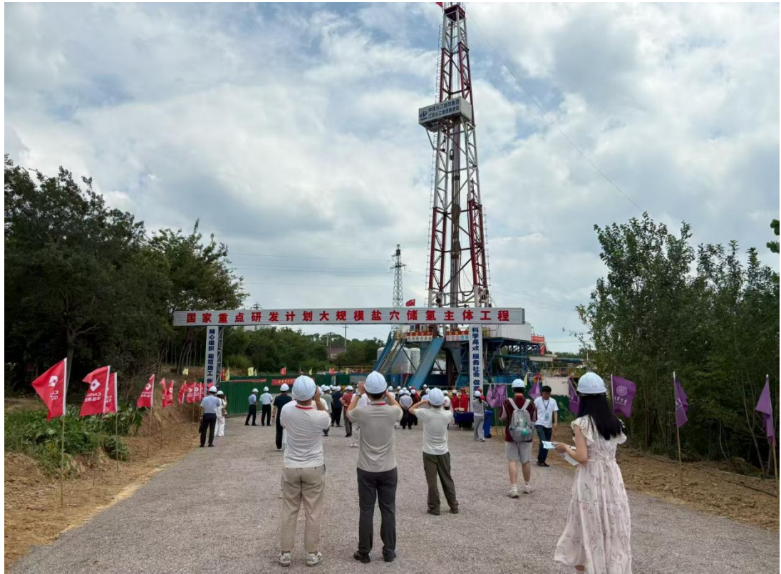
图 2 盐穴储氢库工程现场调研
