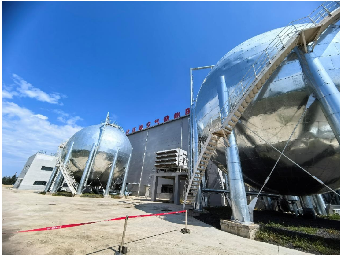
图 4 压缩空气储能库工程现场调研
